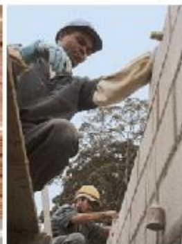
Foto 6. Utilização do prumo na parede
