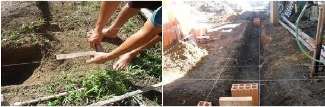
Foto 1 - Pedreiro (A) Esquadrejamento da área a ser Construída
