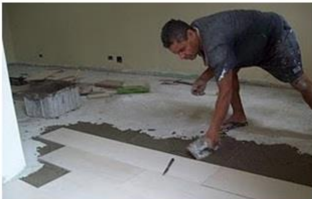
Foto 8. Pedreiro colocando o revestimento cerâmico
