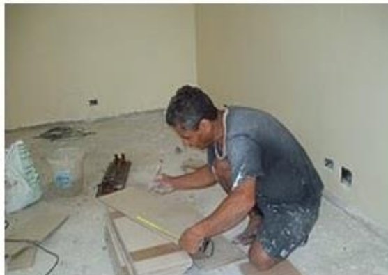
Foto 9. Medindo a cerâmica para fazer um corte
