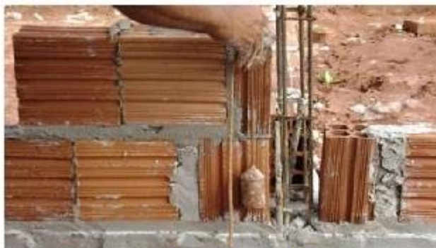
Foto 5. Utilização do prumo no início da construção da parede
