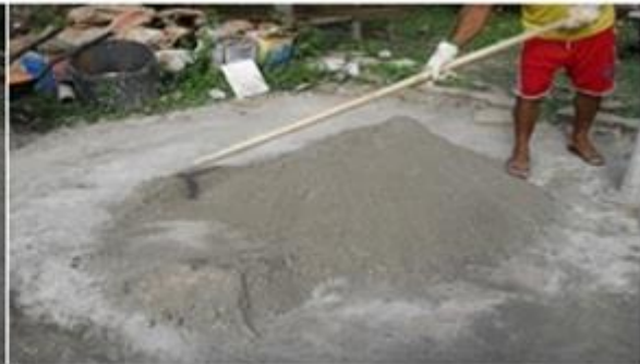
Foto 4. Mistura da areia e cimento
